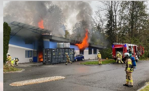
Brandfall im Demo-Center in Kössen (Tirol)
