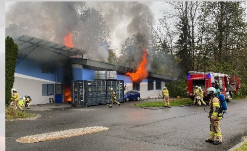
Brandfall im Demo-Center in Kössen (Tirol)
